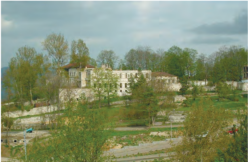
Natəvanın malikanəsinin yerləşdiyi ərazinin qərbdən görünüşü
