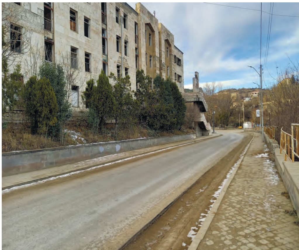
Pənahəli xan küçəsi. Poçtun binası.
