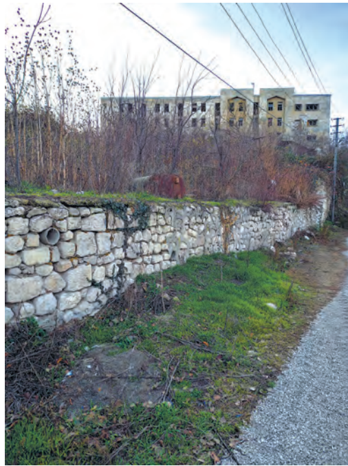
Çöl qala məhəlləsi. Yaşayış evləri. XVIII əsr memarlıq abidəsi idi. İşğaldan sonra ermənilər tərəfindən tam sökülmüşdür. Hətta yola döşənmiş daşları belə çıxarıb aparımışlar.
