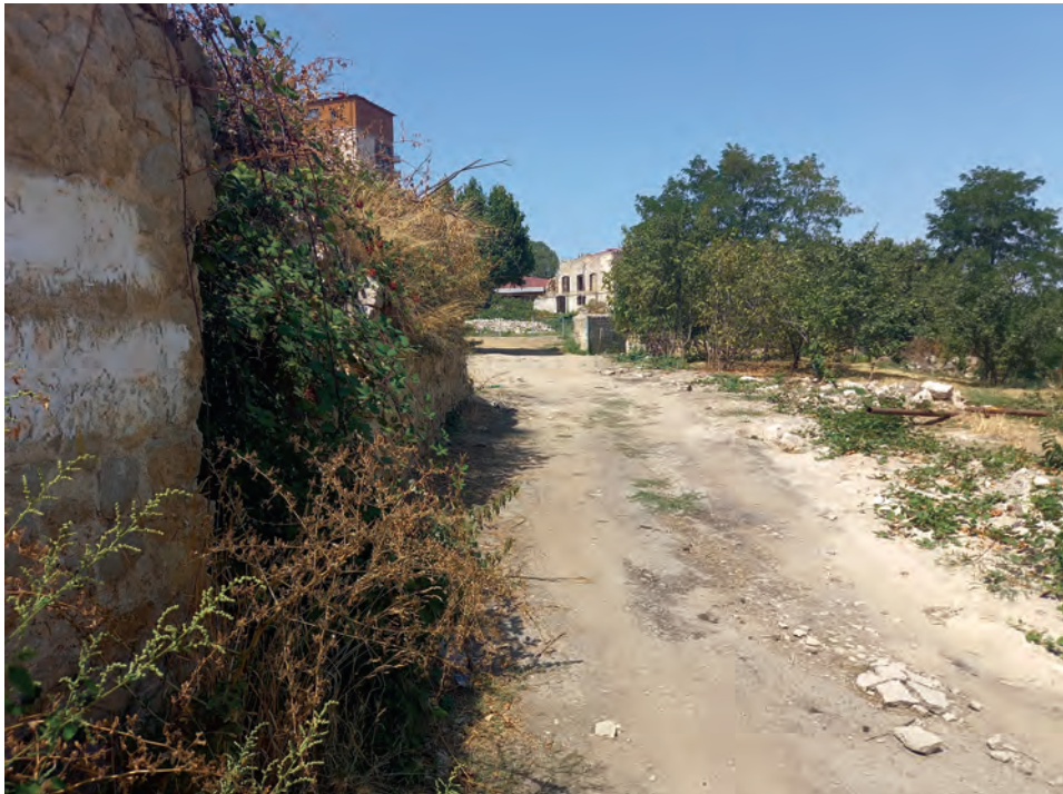
Merdinli mähəlləsi, Sadıqcan küçəsi. İşğaldan sonra mähəllənin bu hissəsindəki XIX əsr memarlıq abidəsi olmuş yaşayış evləri ermənilər tərəfindən tamamilə dağıdılmışdır.
