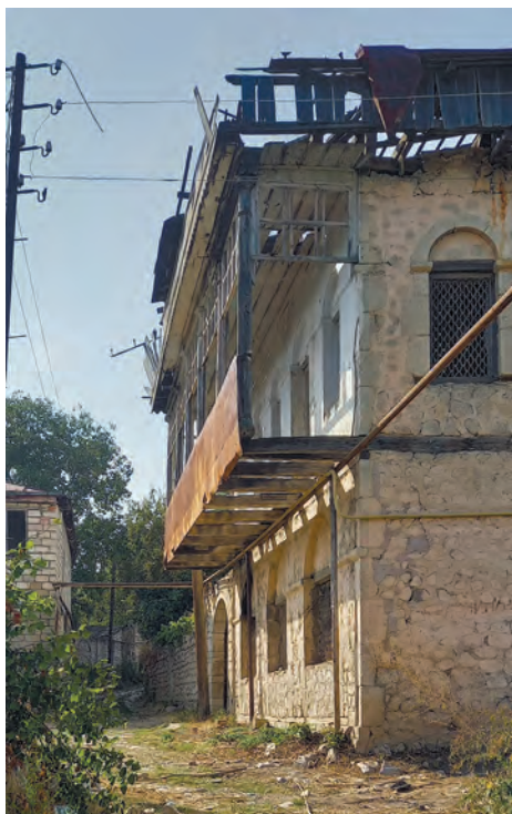
Hamamqabağı məhəlləsi. Yaşayış evi. XIX əsr memarlıq abidəsidir.
