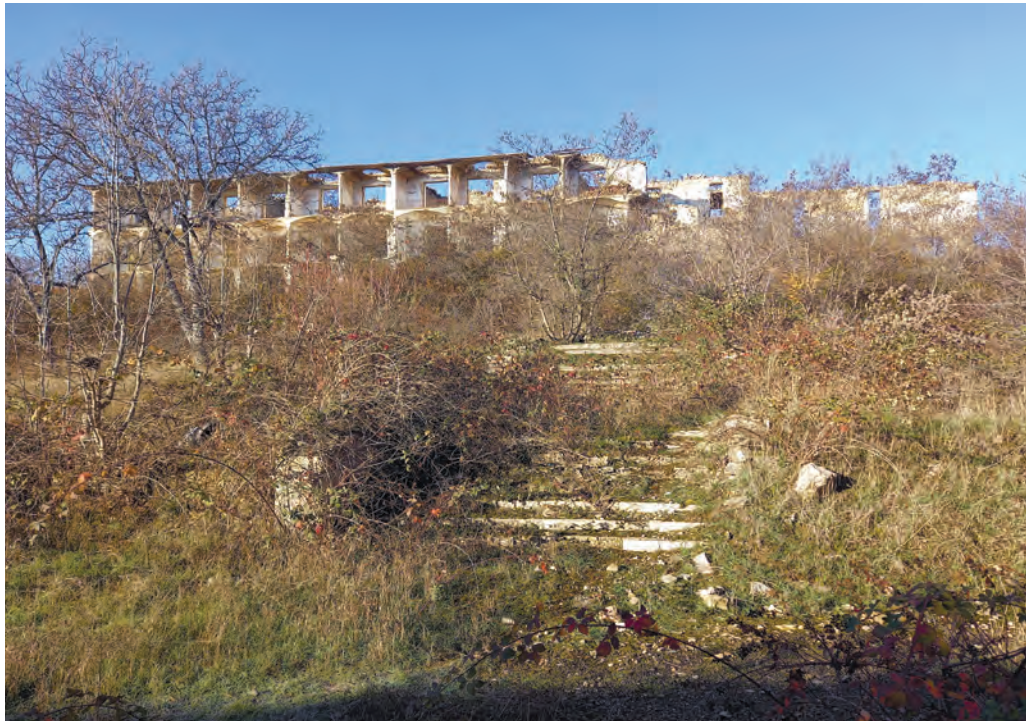
Ümumittifaq miqyaslı “Şuşa” Sanatoriyasının 2 sayılı müalicə korpusunun binası və binanın qarşısında salınmış park
