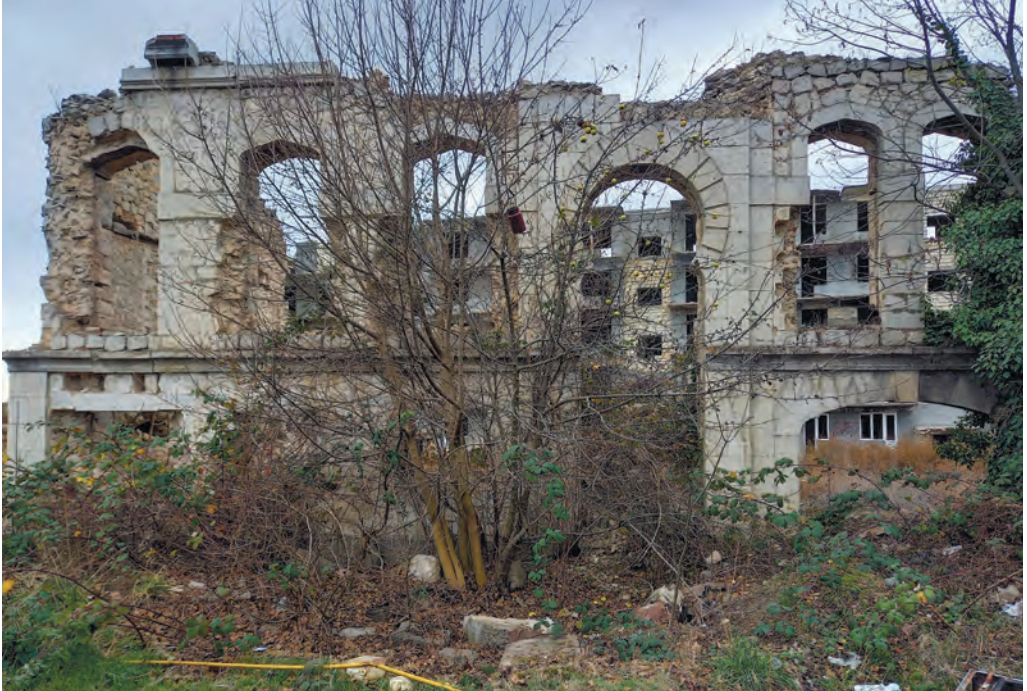
Cahangir xan Nuribəyovun evi. (Şuşa rayon Polis Şöbəsinin inzibati binası). Sadıqcan küçəsi. XIX əsr memarlıq abidəsidir.
