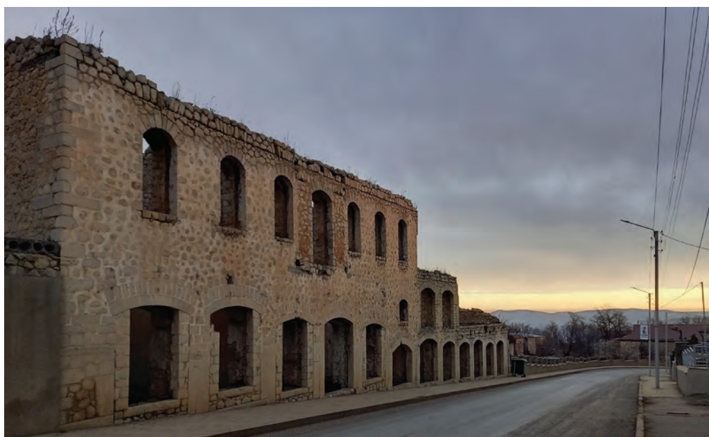
Mamayı məhəlləsi. Yaşayış evləri. XIX əsr memarlıq abidələridir. İşğaldan əvvəl çəkilmiş şəkildə aşağı tərəfdə görünən evlər işğalçılar tərəfindən tam sökülmüşdür. Xarabalıqları belə qalmamışdır.
