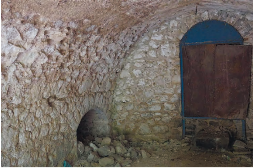
Şuşada XIX əsrdə tikilmiş kanalizasiya kollektoru
