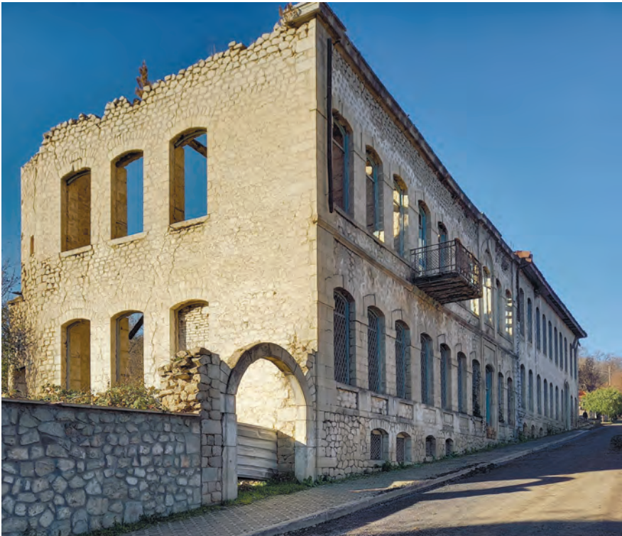
Hamamqabağı məhəlləsi. Yaşayış evləri. XIX əsr memarlıq abidəsidir. Şuşa şəhəri işğal edilənə qədər bu binalarda Texniki Peşə Məktəbi yerləşib.
